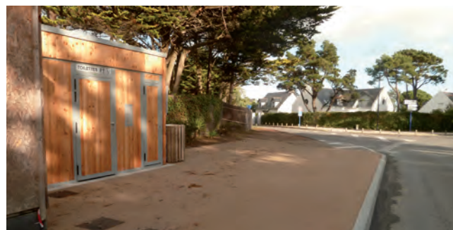
Aménagement du trottoir de Sorlock.
