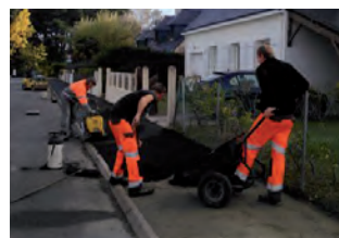
Réfection des trottoirs de la rue de Trévigale.
