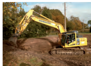
Curage du bassin du Lotissement de la Vigne, afin de prévenir les risques d'inondation dans le bourg de Mesquer.
